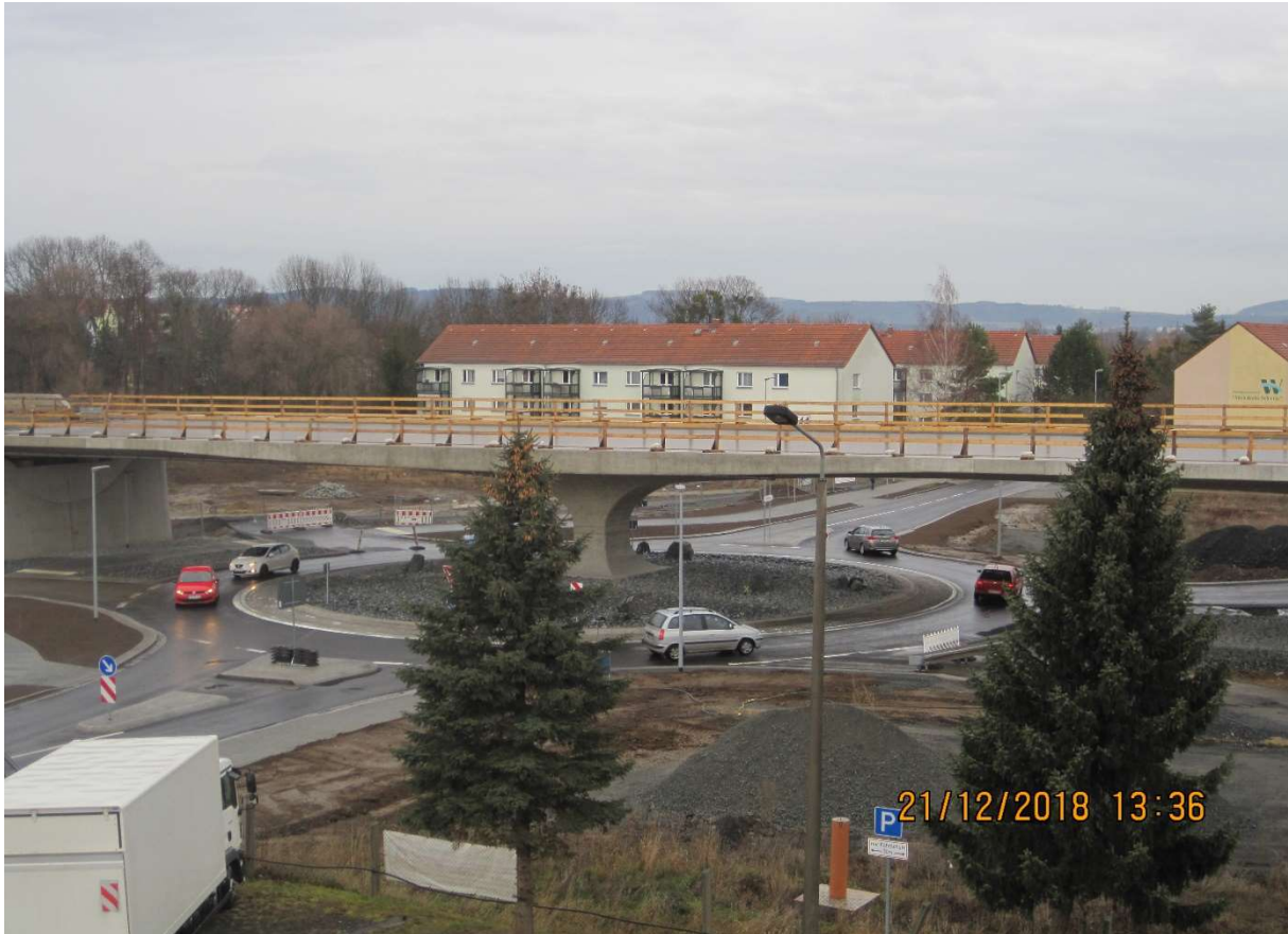
Bild 3 BW 5 mit dem Kreisverkehr, zeigt den fertiggestellten Kreisverkehr mit der Verkehrsfreigabe zum 21.12.2018
