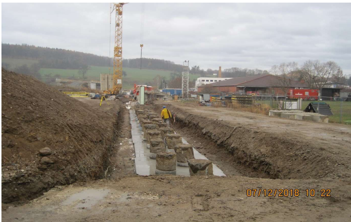
Bild 1 BW 19 Stützwand am Hundesportplatz Blick in Richtung Osten zeigt die Bohrpfahlköpfe für die darauf zu errichtenden Pfahlkopfplatten und den nachfolgenden aufsetzenden Wandsegmenten
