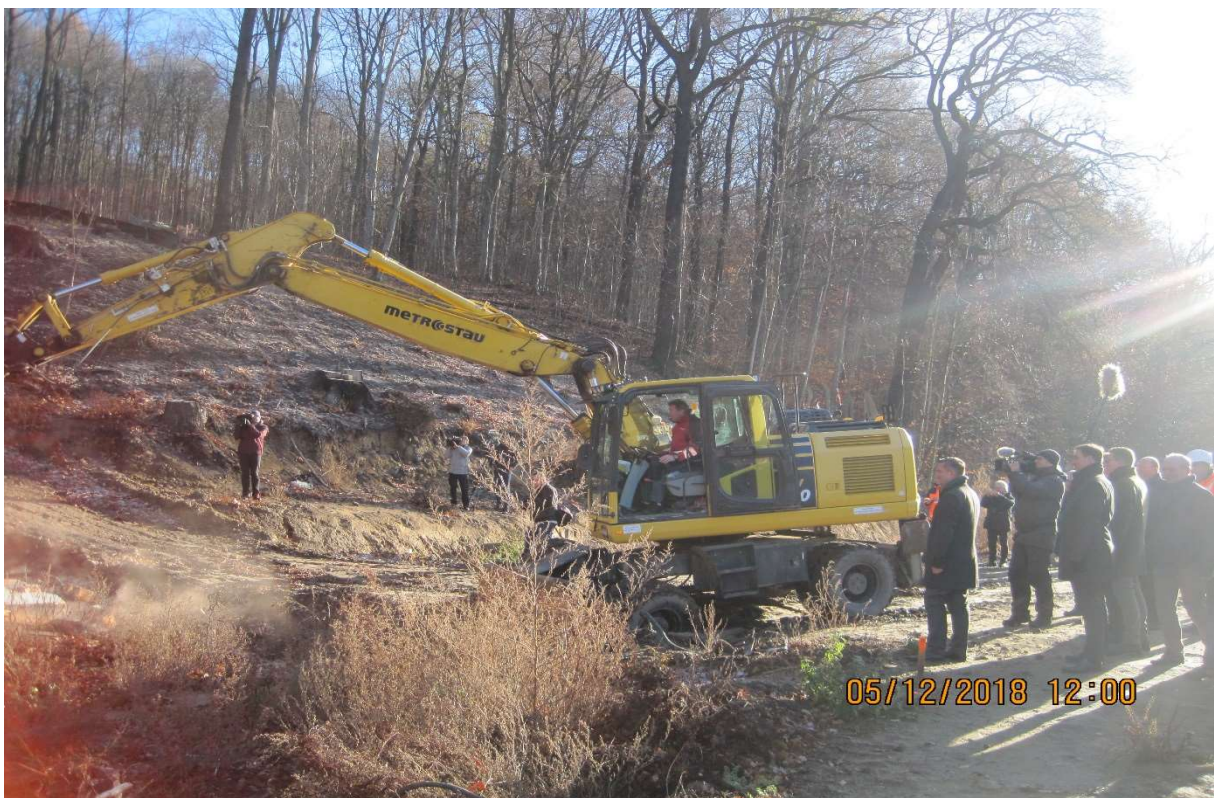
Bild 4 – BW 7 Neubau der Gottliebatalbrücke im Zuge der B172, zeigt den Abbruch eines Trafohäuschen mit dem Pressetermin für den Baubeginn
