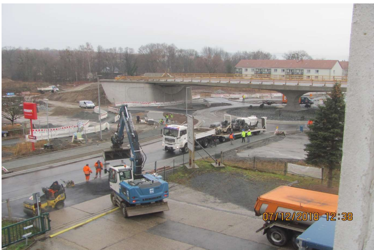
Bild 2 BW 5 mit dem Kreisverkehr, zeigt den Einbau der Asphaltdeckschicht unter halbseitiger Sperrung nach genehmigter VAO
